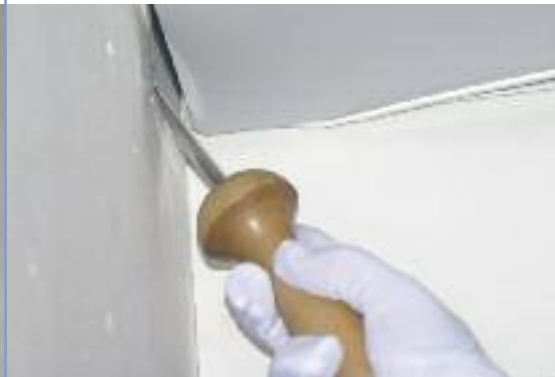
Einhängen der Decken mit CILING-Spachtel Fitting the ceiling with the CILING®-spatula
