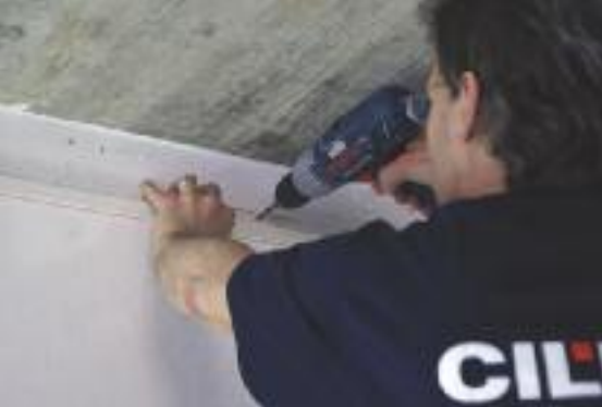
Anschrauben der Profilleisten Bolting the profiles
