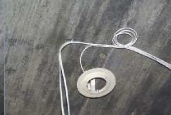
Leitungen zu allen Unterkonstruktionen ziehen Installing the wires for the lighting
