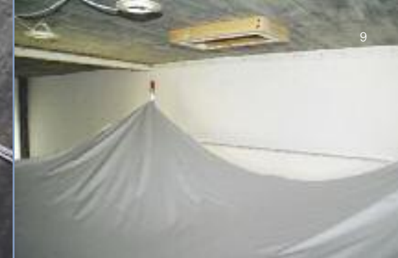
Decke an allen Ecken mit Klammern aufhängen The stretched ceiling is clamped at all corners
