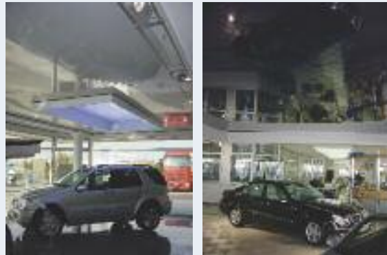
Autohaus – links: weiße Glanzdecke mit blauem Lichtdeckenfeld rechts: dunkelblaue Glanzdecke Auto dealer – left: white glossy ceiling with inserted blue lighted ceiling right: dark blue glossy ceiling Ausführung/Contractor: Die Schreinerwerkstatt Kaufmann + Hofmann, Bad Windsheim
