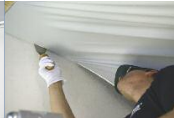
Einhängen der Decke Fitting the ceiling
