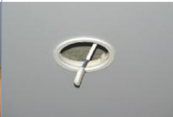
Vorbereiteter Ausschnitt für den Leuchteneinbau Opening for installation of lighting
