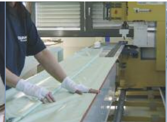
Einzelne Bahnen miteinander verschweißen Welding the individual panels together
