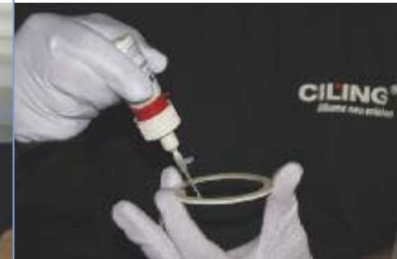
Ring für Downlights mit CILING-Kleber versehen Attaching the ring for the lighting with CILING®-glue
