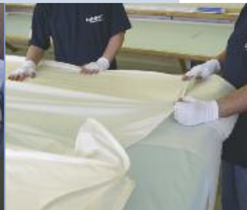
Kontrolle der gekederten Decke Checking the rimmed stretched ceiling
